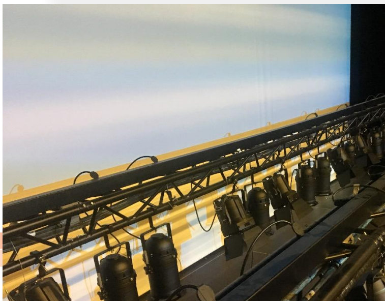
Ciclorama instalado en Cal Carrera, Sallent
